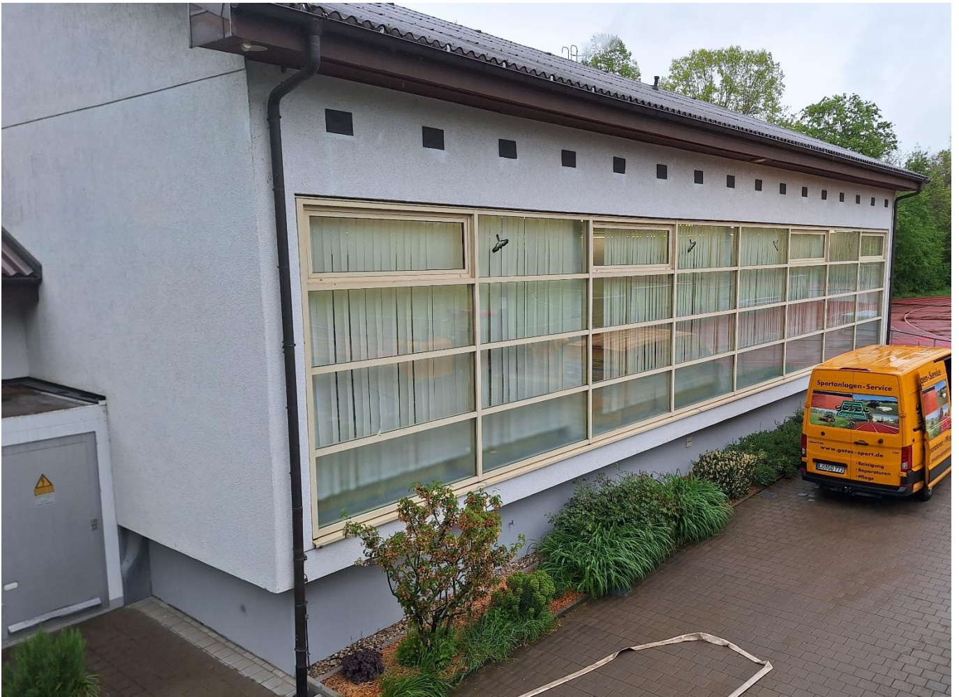
Ansicht Ost – Pfosten-Riegel-Fassade
